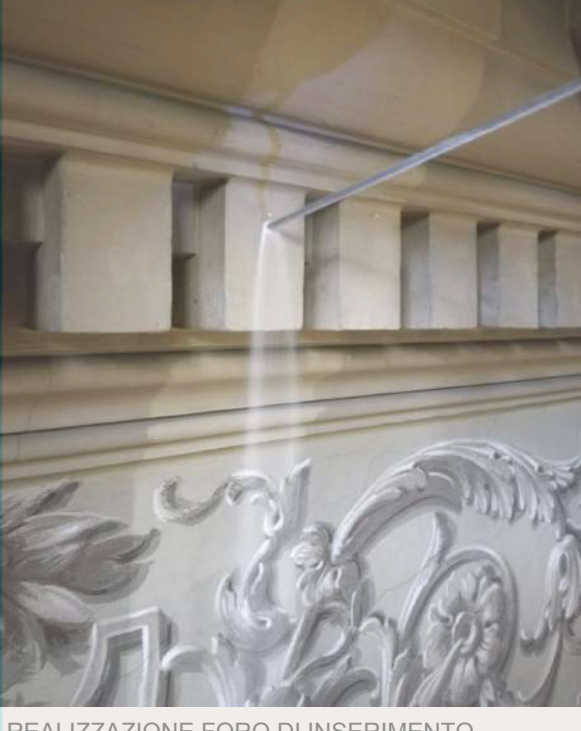
REALIZZAZIONE FORO DI INSERIMENTO
