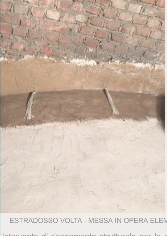
ESTRADOSSO VOLTA - MESSA IN OPERA ELEMENTI DI COLLEGAMENTO
