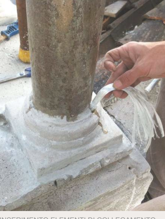
INSERIMENTO ELEMENTI DI COLLEGAMENTO
