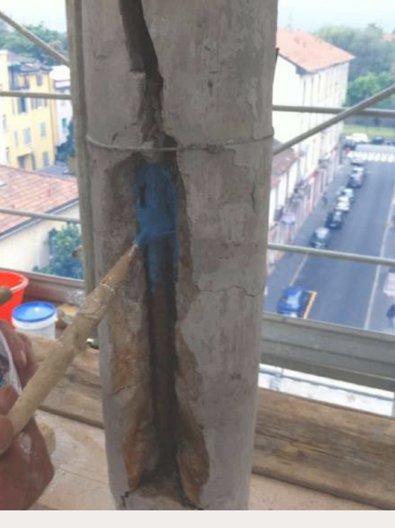
PULIZIA E APERTURA CREPA
