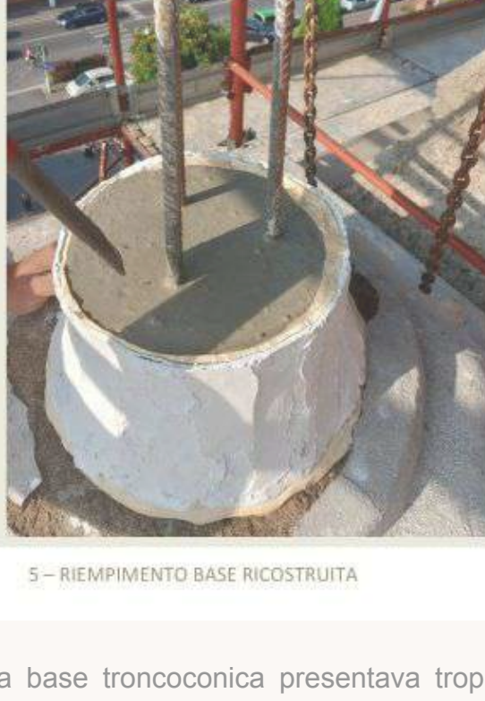
5 – RIEMPIMENTO BASE RICOSTRUITA
